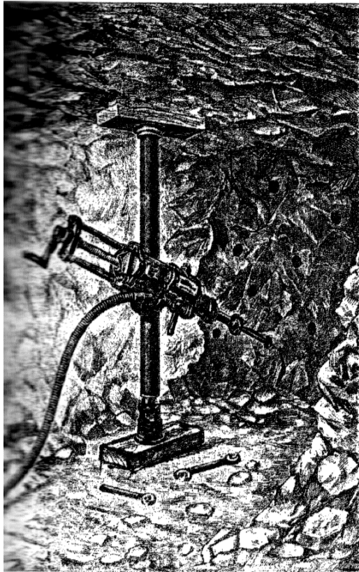
Рис 1.10. Перфоратор Мейера, установленный на распорной колонке
