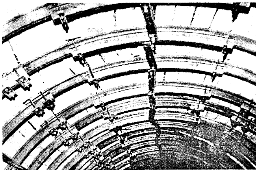
Рис. 6.5. Арочная усиленная крепь: а — конструкция; б — приемочные испытания в условиях шахты им. 50-летия СССР ПО «Краснодонголь»
